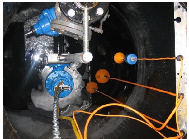
Richtige Positionierung der Niveauregler
