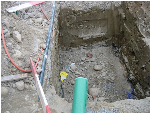
Aushub der Grube durch den Baumeister
