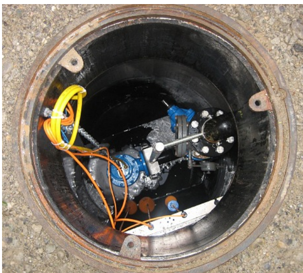
Die betriebsbereite Anlage kann dem Kunden übergeben werden.
