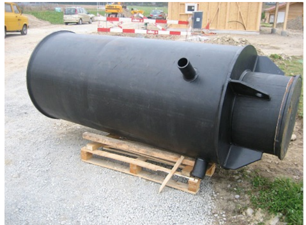
Anlieferung des Fertigpumpenschachtes auf der Baustelle. Kupplungssystem, Druckleitung und Armaturen sind bereits vormontiert.
